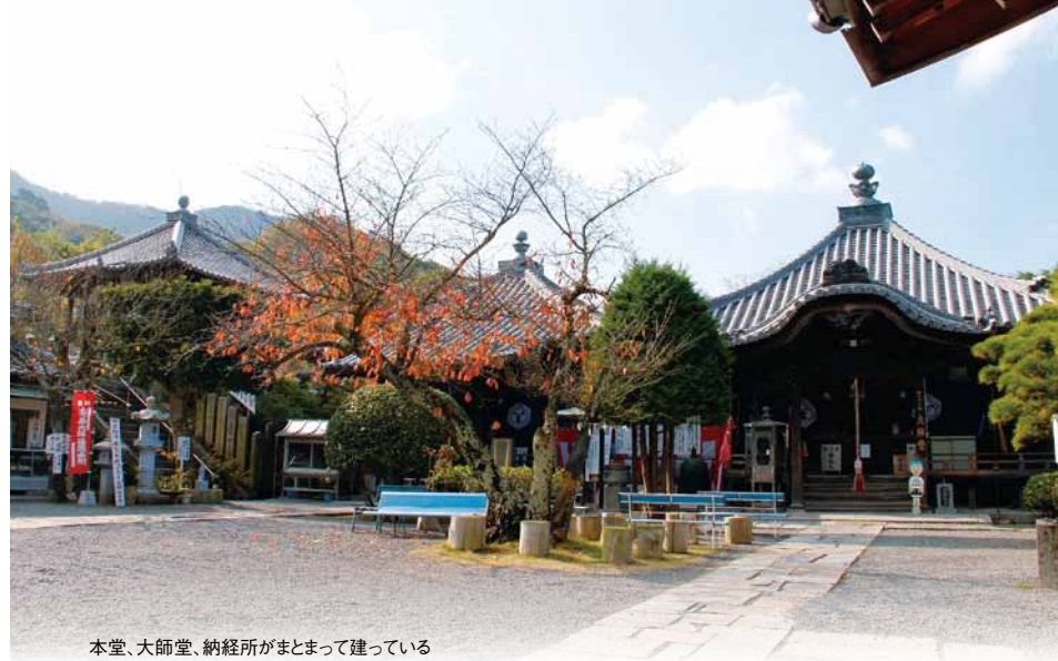
本堂、大師堂、納経所がまとまって建っている
